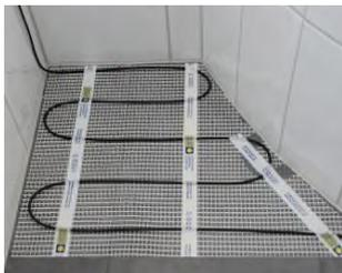
Millimeter-Heizmatte zur Einbettung in Ausgleichsmasse oder Flexkleber direkt unter dem Fussbodenbelag. Aufbauhöhe nur 3mm. Dipolar - mit nur einem Anschlusskabel. **Alle Formen, Grössen und Leistungen sind möglich.**
